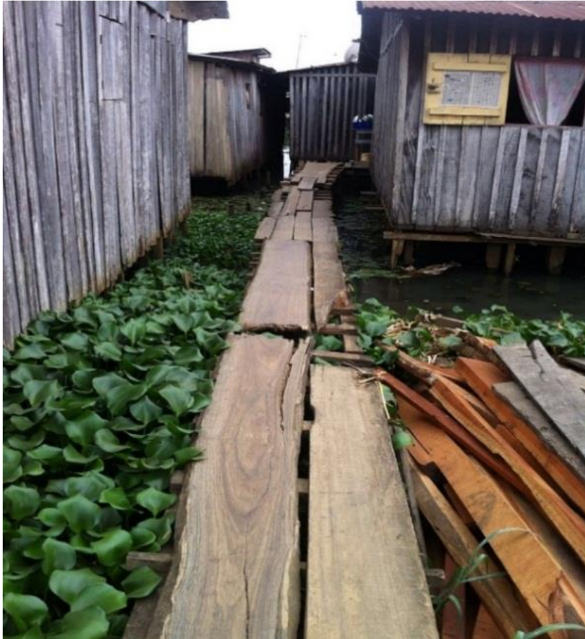
Photo 4 : Vues des logements construits dans un lit de rivière au carrefour SNI (juillet 2016)
